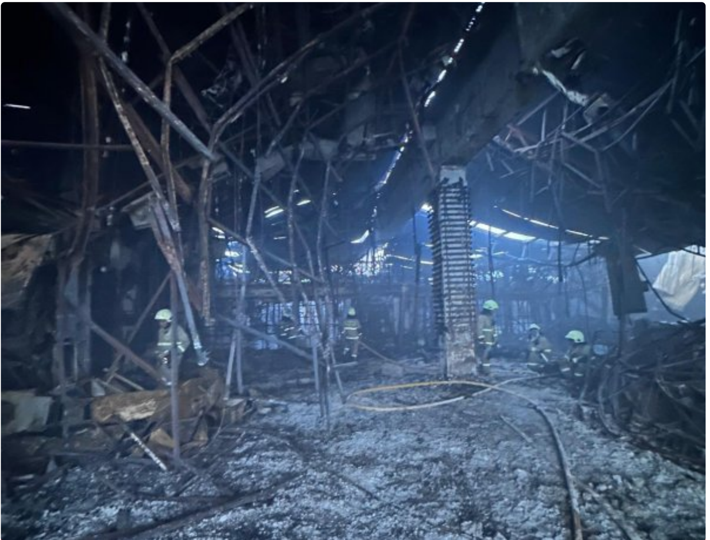
Glodok Plaza yang Hangus Terbakar
